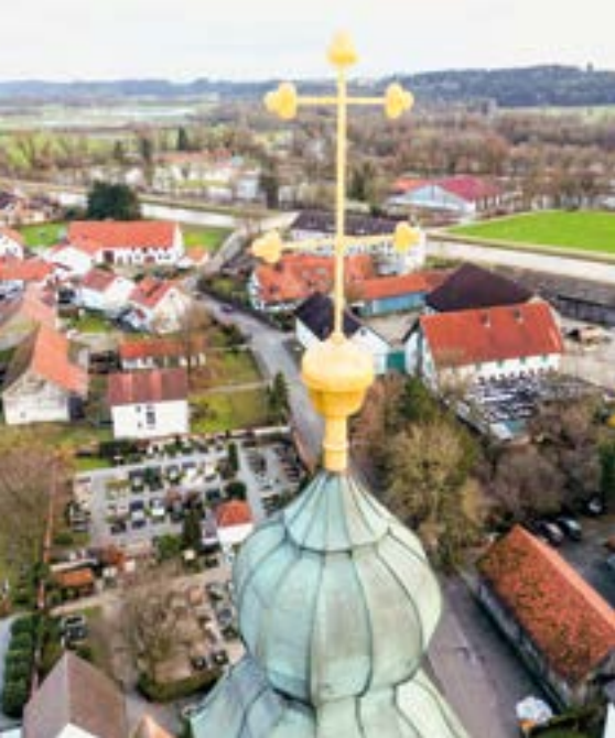
Das Kreuz auf der Turmspitze wird im Zuge der Arbeiten neu vergoldet. Dann kann es wieder über das Ampertal hinweg strahlen.
